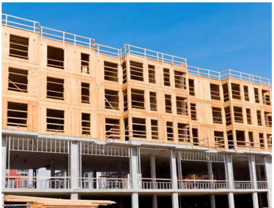
sich die Elemente im Aufbau. Die Anzahl der Lagen oder Dicke der einzelnen Brettschichten werden variiert. Die Hersteller stellen jeweils allgemeine bauaufsichtliche Zulassungen zur Verfügung, denen die charakteristischen Festigkeits- und Steifigkeitswerte zu entnehmen sind. Man kann allerdings von einer vergleichbaren Dicke der Decke ausgehen, im Vergleich zu den zuvor genannten Brettschichtholzelementen.
