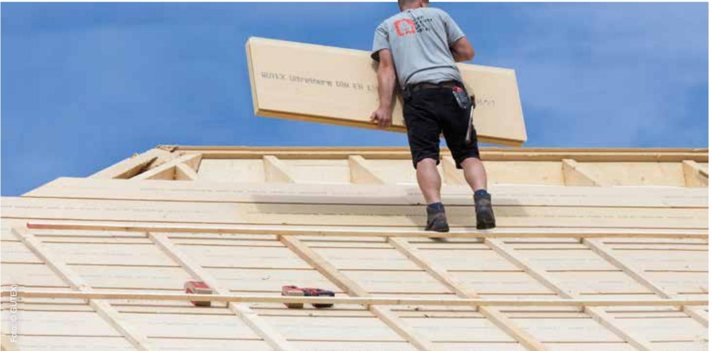
*GUTEX Ultratherm: Die Aufdachdämmung aus Holzfaser lässt sich fugenfrei verlegen und schützt das Dach sicher vor Witterungseinflüssen.*
