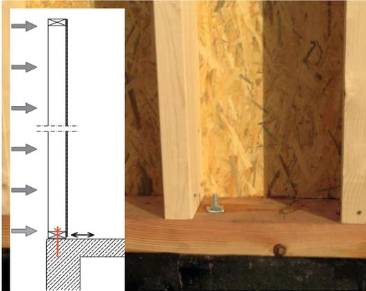
Vertikale Verankerung: Das Verankerungselement (Zuganker) sichert die Wand gegen Abheben. An der vertikalen Rippe wird mit einer hohen Anzahl von Verankerungsstiften (Sondernägeln) eine hohe Last in den Stahlwinkel eingeleitet (Foto in Abb. 44). Der Dübel reicht durch die Schwelle in den Betonunterbau und liegt nahe der langen Metalllasche, um eine Verformung des Stahlbauteils möglichst gering zu halten
