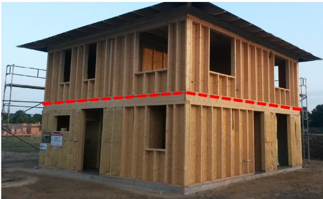
**Abb. 94:** Die Lasten sollen dorthin geleitet werden wo die steifen Wände als Auflager der Deckenscheibe zur Verfügung stehen. Die Deckenscheibe muss kraftschlüssig an die Wandelemente angeschlossen werden.
