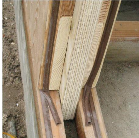
**Tabelle 102:** Elementverbindung mit Stoßbrettern aus Holzwerkstoffplatten (OSB oder Sperrholz). Bilder: Meyer Ingenieurbüro
