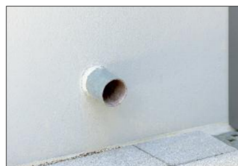
Minimaler Fassadendurchbruch für die Notentwässerung mit einem schmalen DN-50-Rohr.
