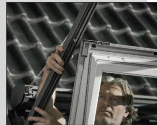
Für Effizienzsteigerungen beim Einbau des neuen Rollladens sorgen beispielsweise Klick-on-Lösungen: Sie reduzieren Einbauschritte und gewährleisten eine schnelle sowie sichere Montage von innen.
